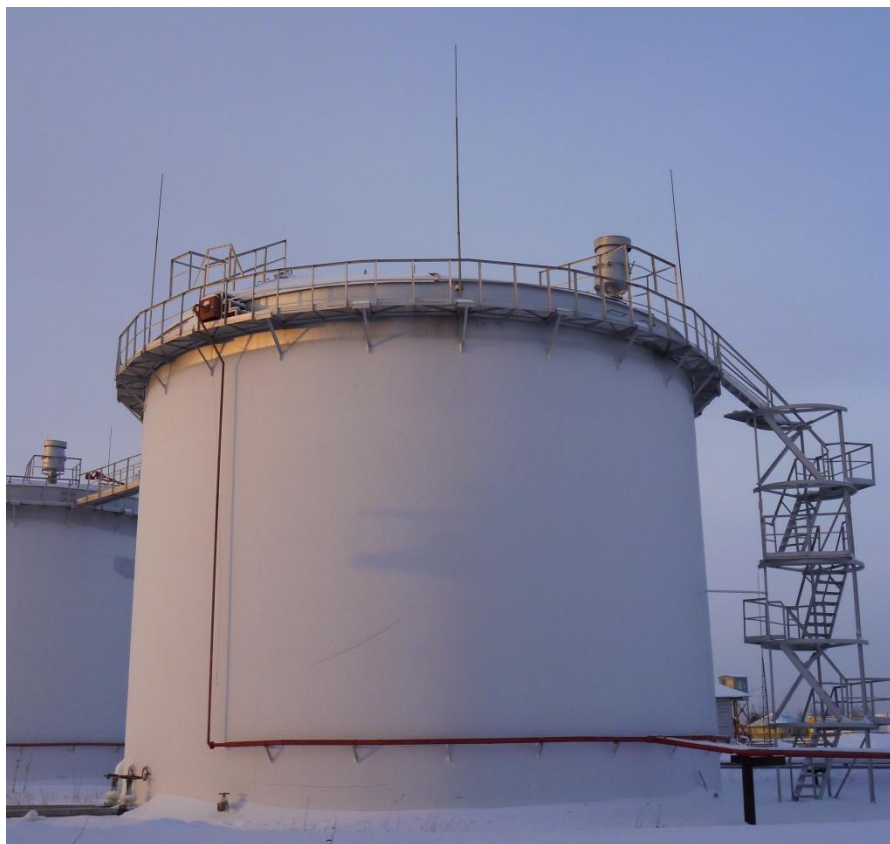
Рисунок 1 - Общий вид резервуара РВС-2000
