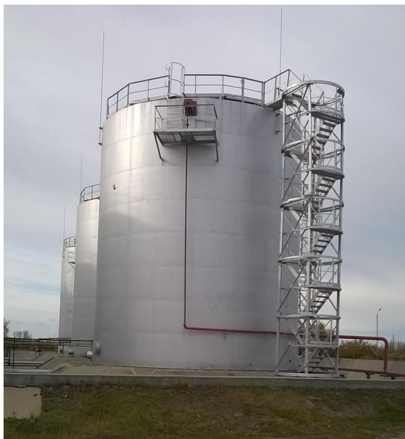
Рисунок 1 - Общий вид резервуара РВС-1000
