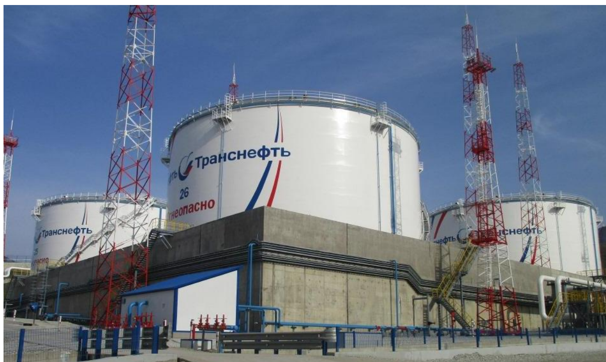
Рисунок 1 – Общий вид резервуара РВСП-30000
