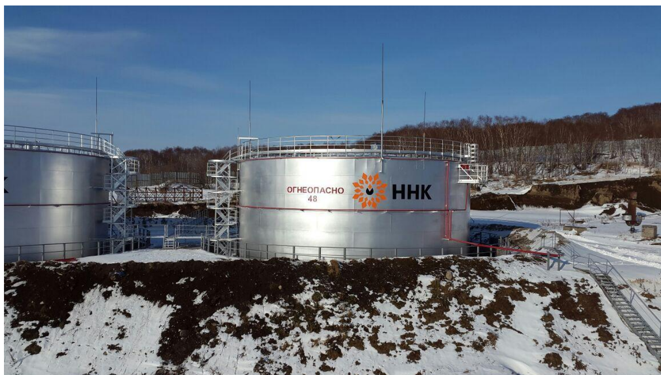
Рисунок 1 - Общий вид резервуара РВС-5000
