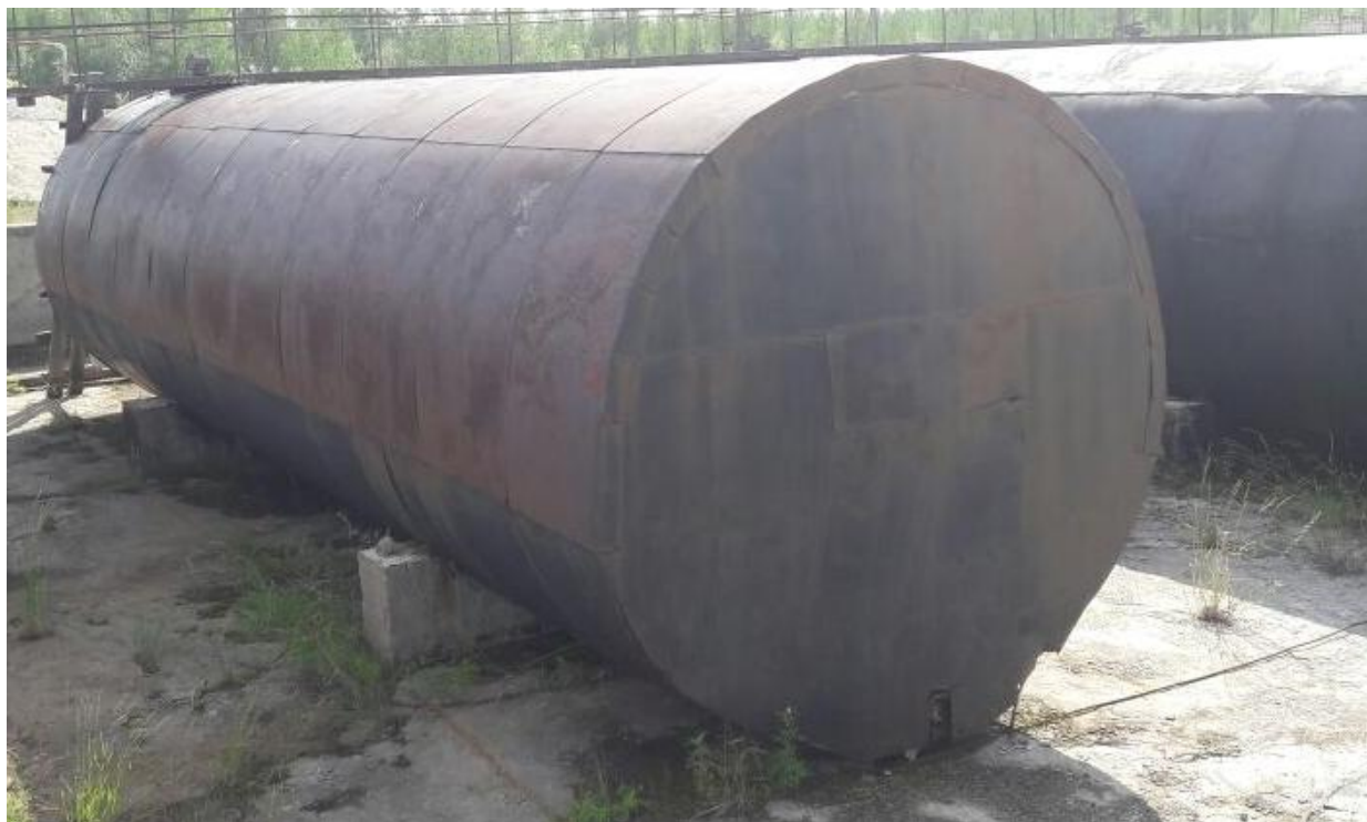
Рисунок 1 - Общий вид резервуара РГС-60
