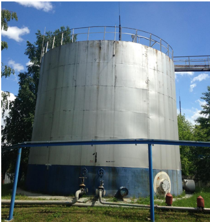
Рисунок 1 - Общий вид резервуара вертикального стального цилиндрического РВС-700
