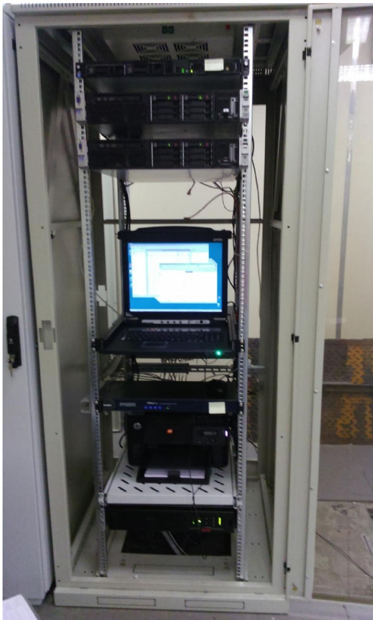
Рисунок 1 - Вычислитель АСУТ-601М2 (шкаф, вид спереди с открытой дверцей)
