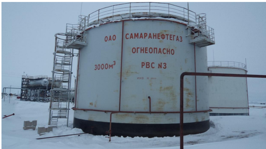
Рисунок 3 - Общий вид резервуара стального вертикального цилиндрического РВС-3000
