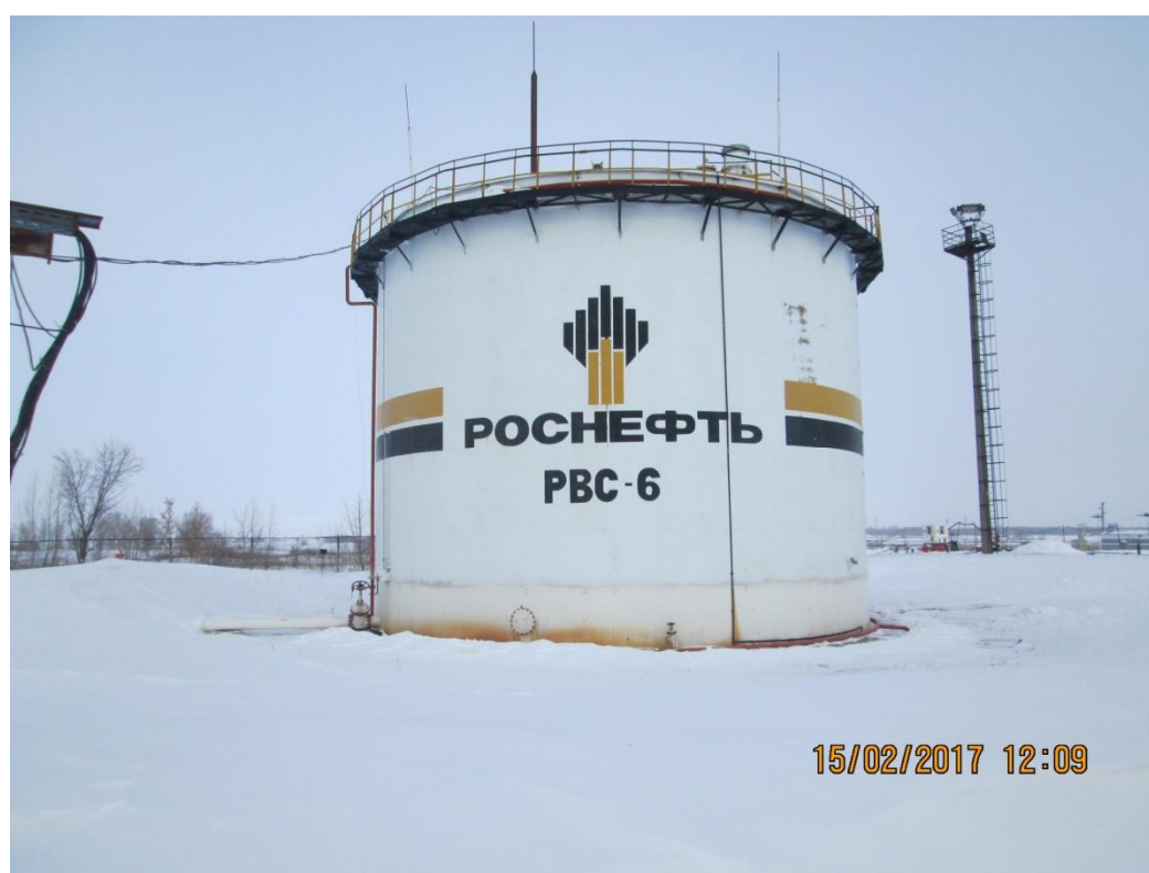
Рисунок 2 - Общий вид резервуара стального вертикального цилиндрического РВС-2000
