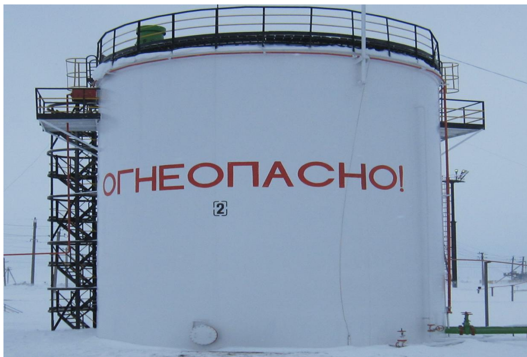
Рисунок 1 - Общий вид резервуара стального вертикального цилиндрического РВС-1000
