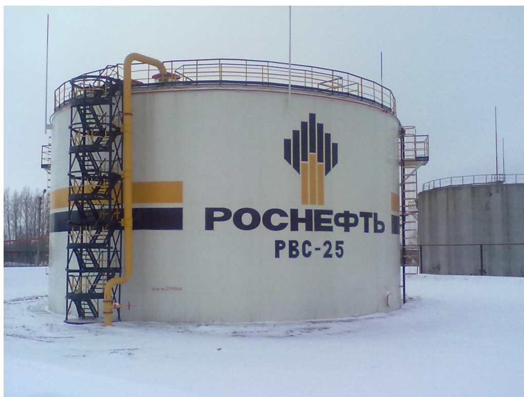
Рисунок 2 - Общий вид резервуара стального вертикального цилиндрического РВС-5000
