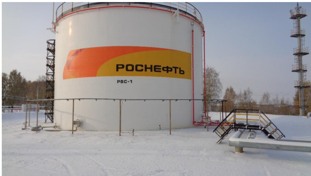
Рисунок 1 - Общий вид резервуара стального вертикального цилиндрического РВС-3000
