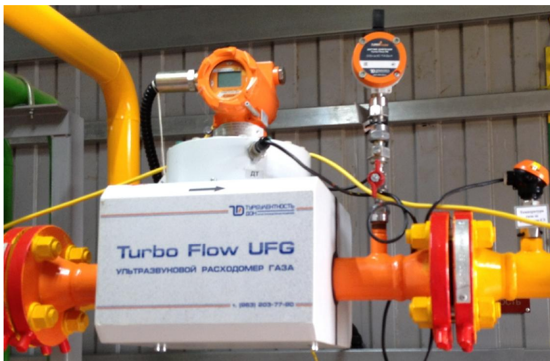
Рисунок 1 - Общий вид расходомера - счетчика газа ультразвукового Turbo Flow UFG - F
