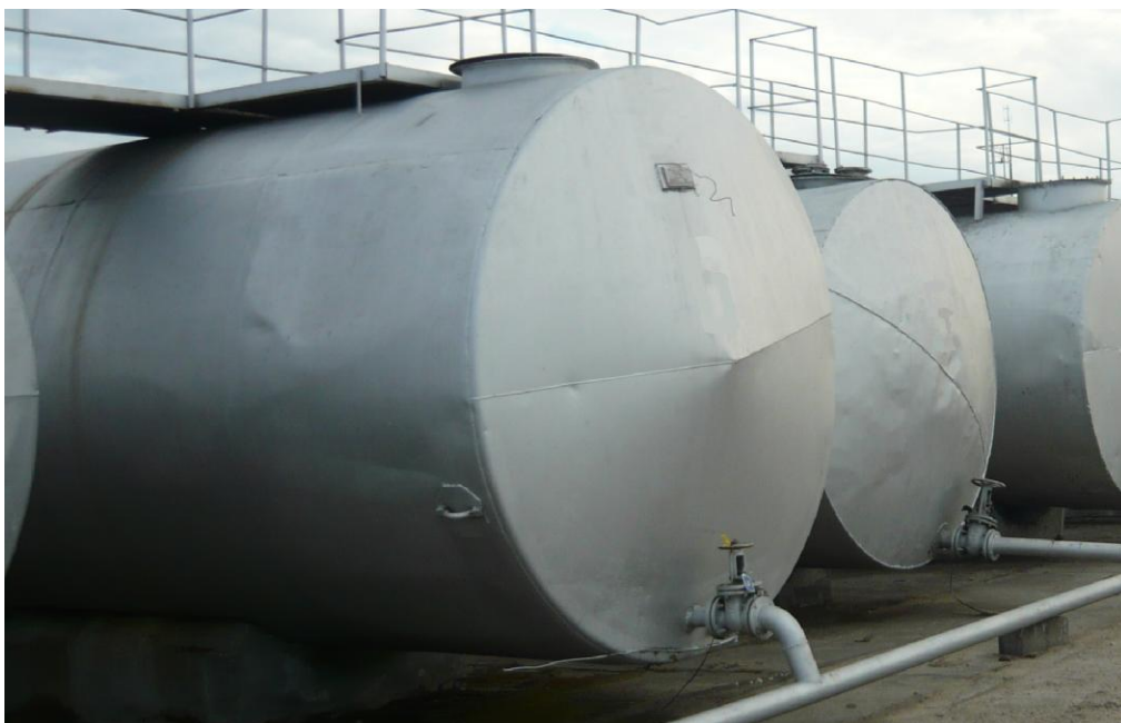
Рисунок 2 - Общий вид резервуара РГС-60
