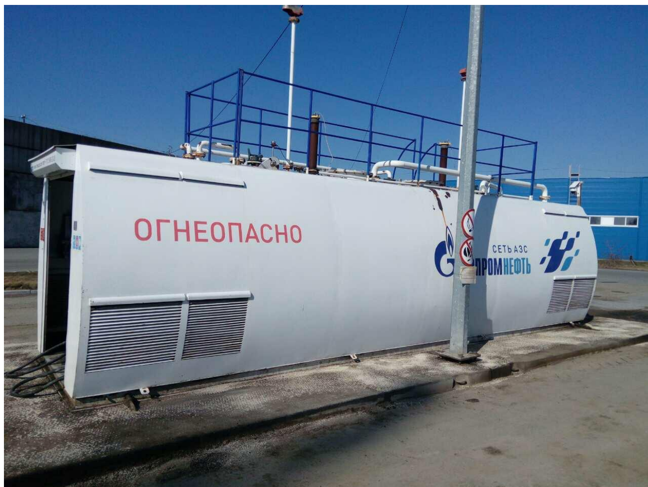
Рисунок 1 - Общий вид резервуара РГС-20
