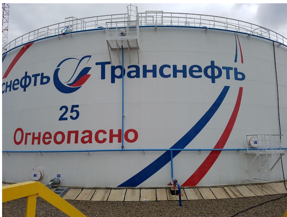
Рисунок 1 - Общий вид резервуара вертикального стального цилиндрического РВСП-20000
