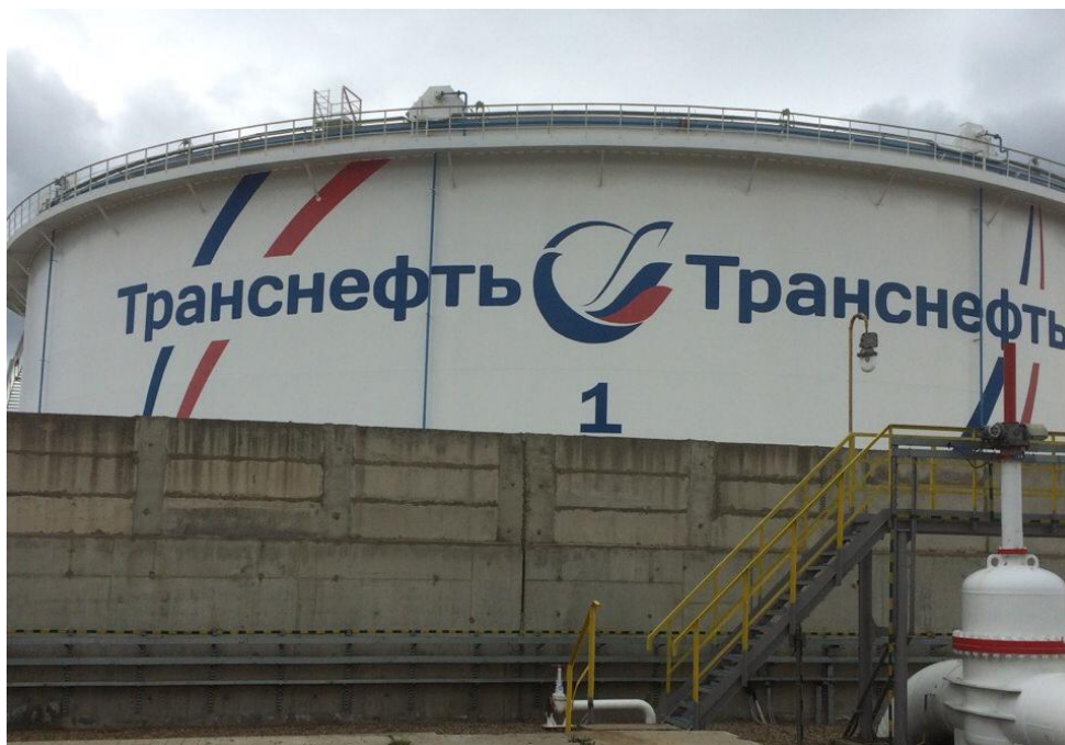
Рисунок 2 - Общий вид резервуара вертикального стального цилиндрического РВСПК-50000
