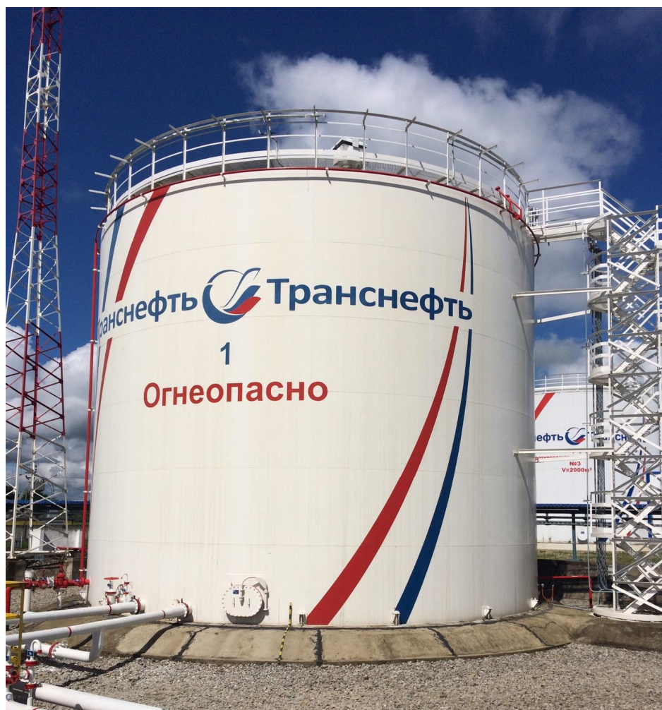
Рисунок 1 - Общий вид резервуара вертикального стального цилиндрического РВС-2000
