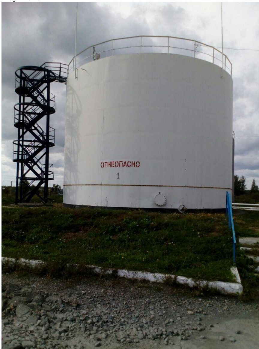
Рисунок 1 – Общий вид резервуара вертикального стального цилиндрического РВС-1000
