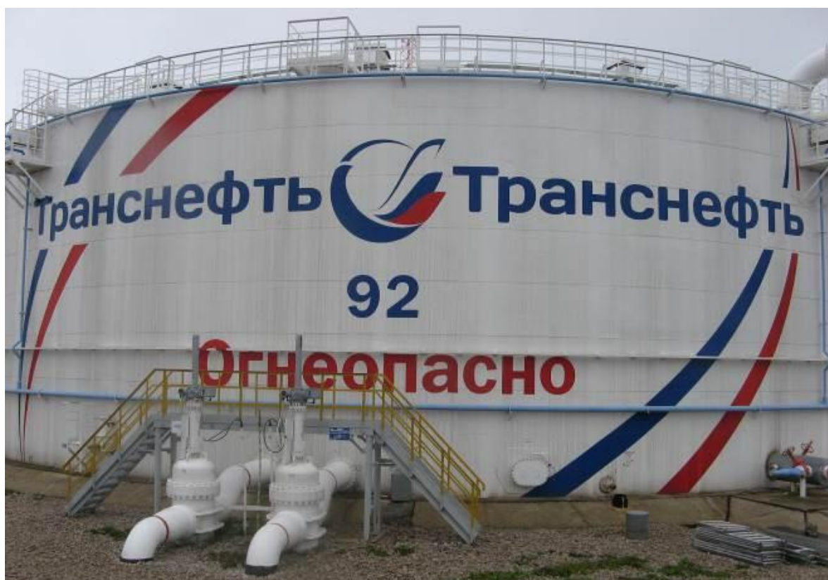
Рисунок 2 - Общий вид резервуара вертикального стального цилиндрического РВС-20000
