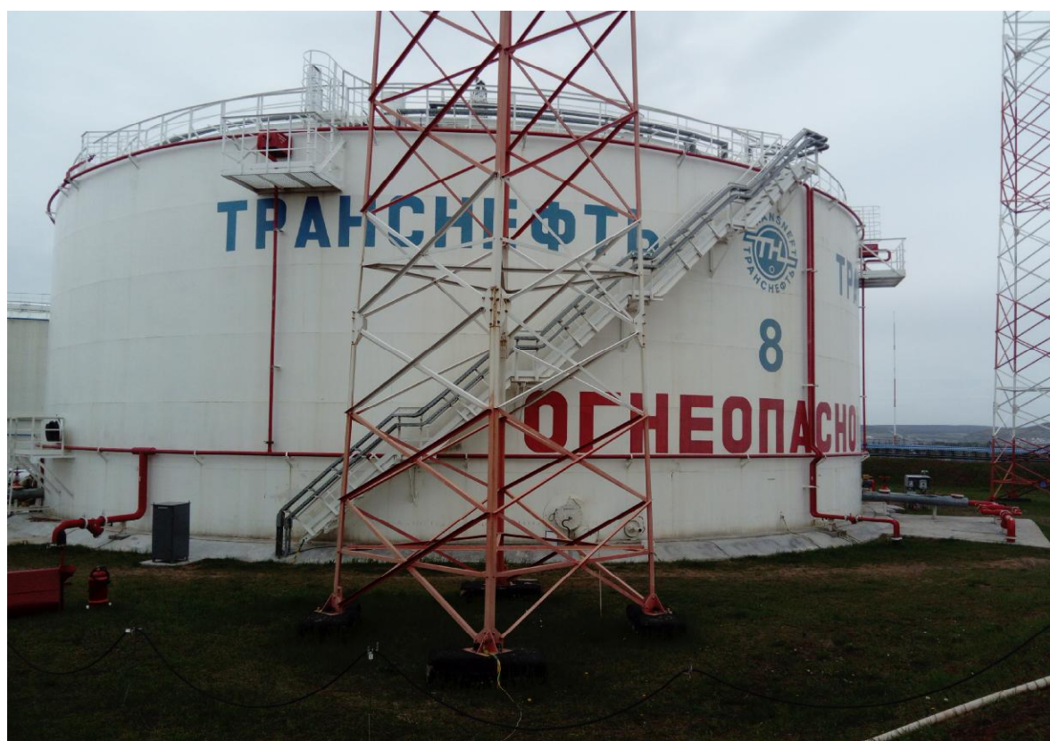
Рисунок 3 - Общий вид резервуара вертикального стального цилиндрического РВСП-10000
