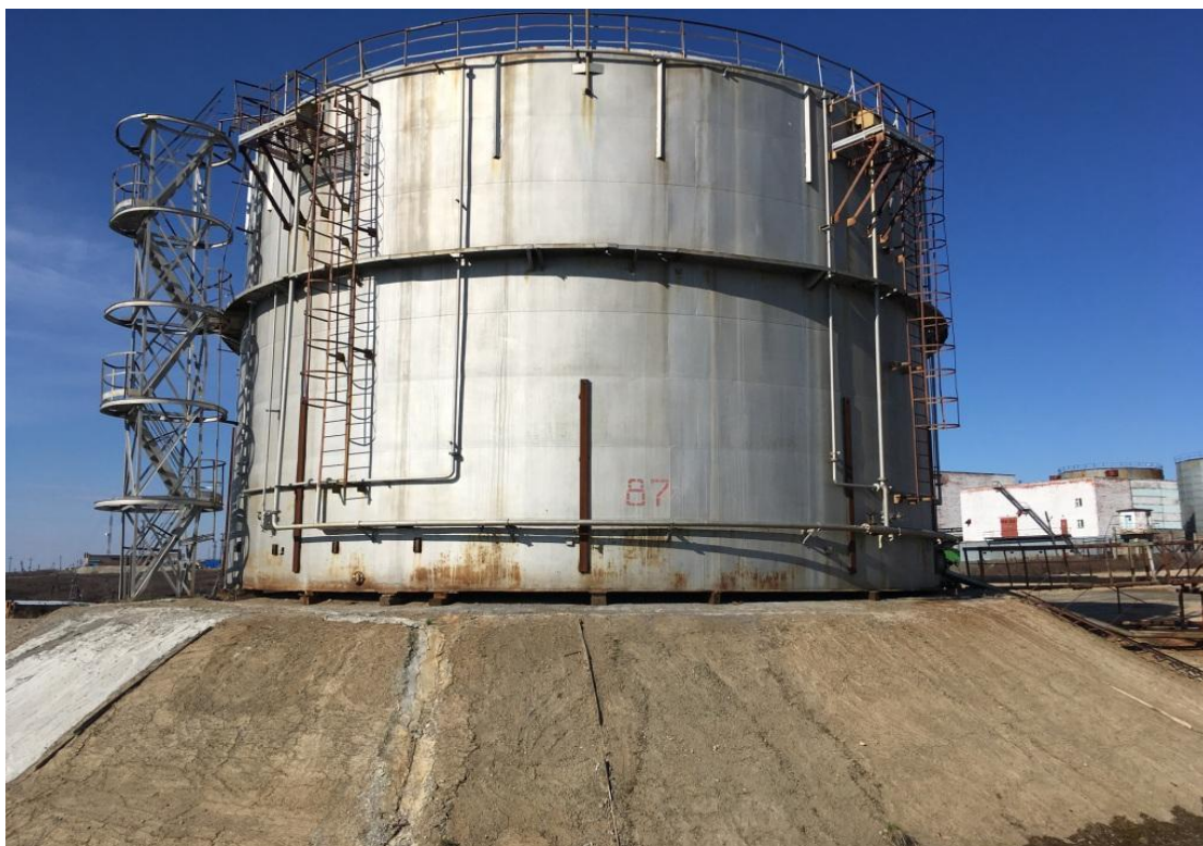
Рисунок 4 - Общий вид резервуара стального вертикального цилиндрического РВС-3000
