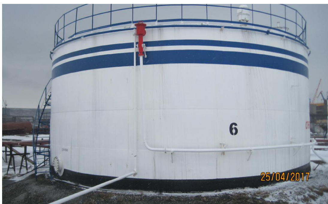
Рисунок 2 - Общий вид резервуара стального вертикального цилиндрического РВС-1000
