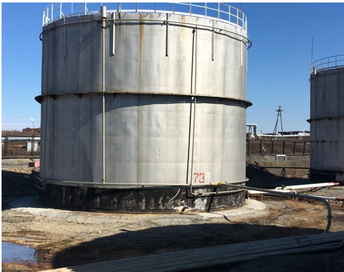
Рисунок 3 - Общий вид резервуара стального вертикального цилиндрического РВС-2000
