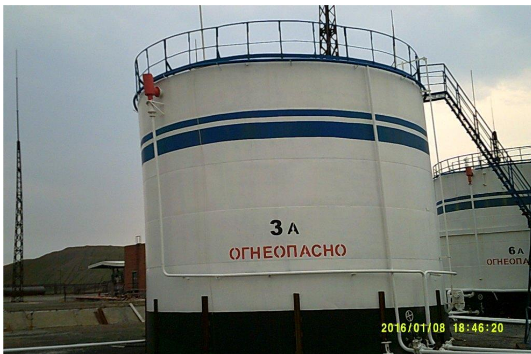
Рисунок 1 - Общий вид резервуара стального вертикального цилиндрического РВС-700
