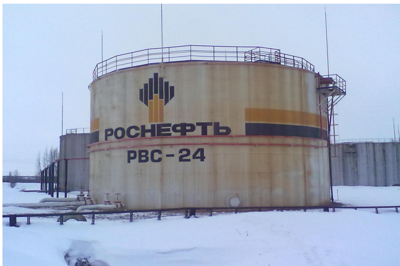
Рисунок 4 - Общий вид резервуара стального вертикального цилиндрического РВС-4000
