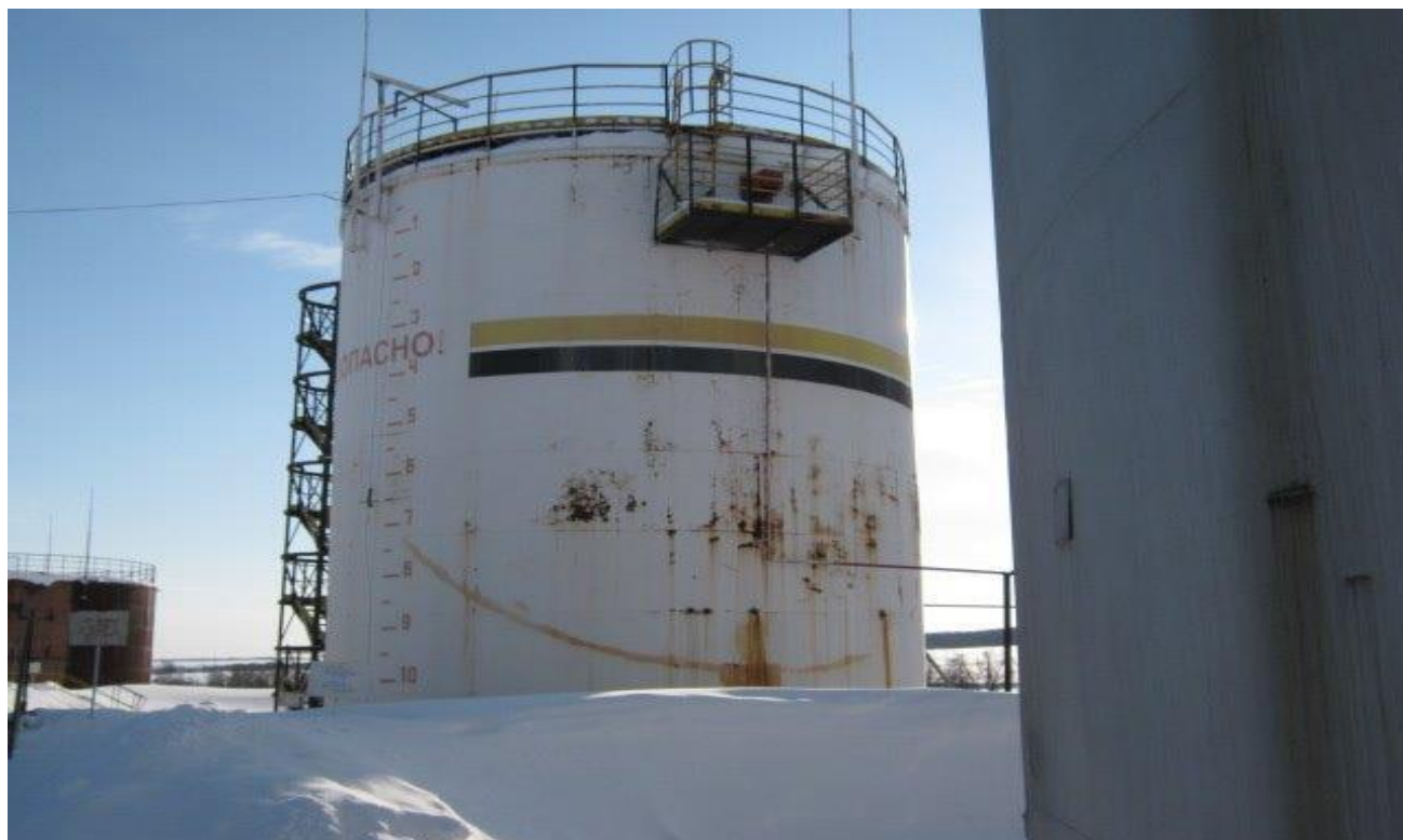
Рисунок 1 - Общий вид резервуара стального вертикального цилиндрического РВС-1000
