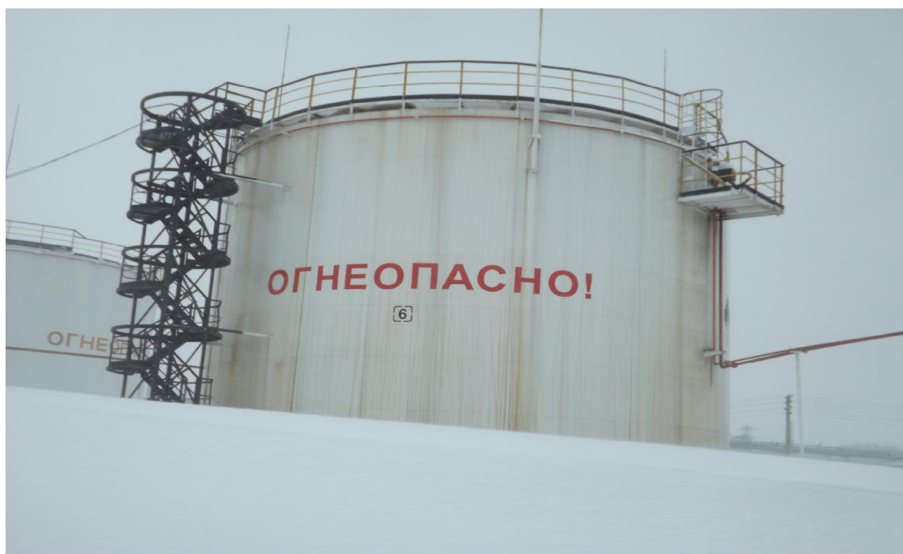
Рисунок 2 - Общий вид резервуара стального вертикального цилиндрического РВС-2000
