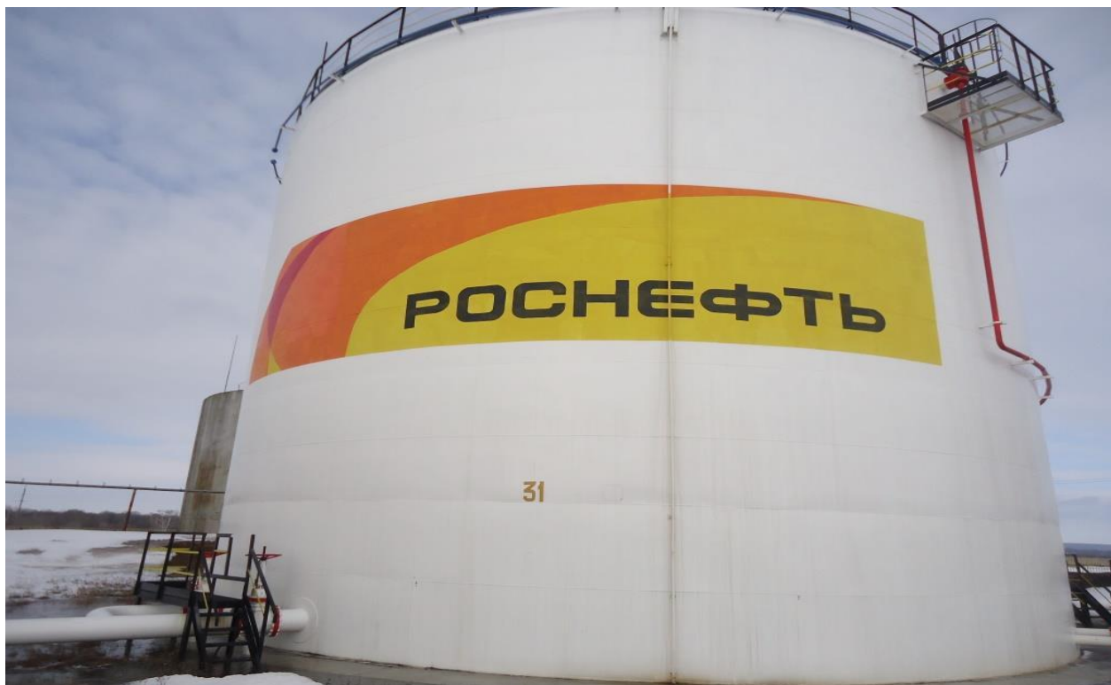
Рисунок 5 - Общий вид резервуара стального вертикального цилиндрического РВС-5000
