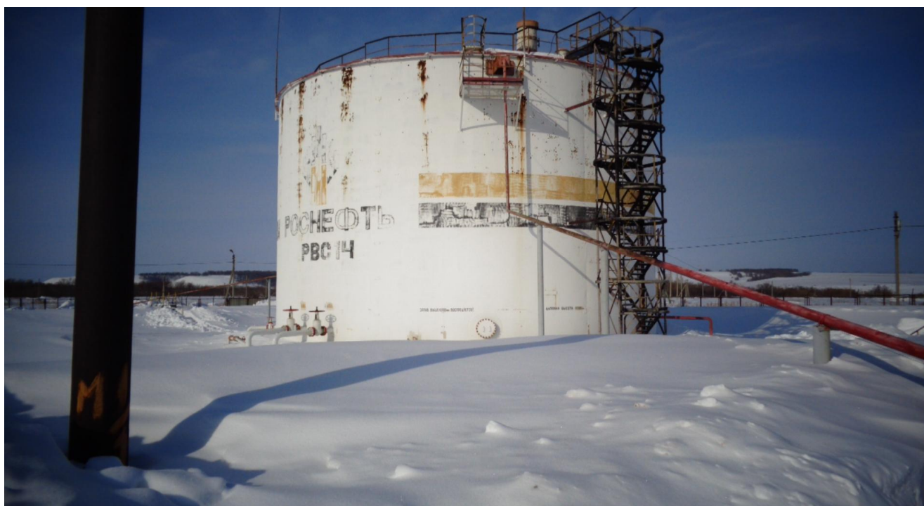
Рисунок 3 - Общий вид резервуара стального вертикального цилиндрического РВС-3000
