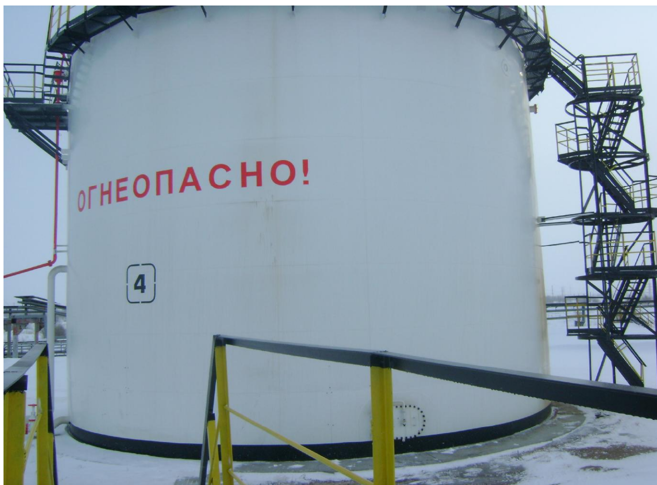
Рисунок 2 - Общий вид резервуара стального вертикального цилиндрического РВС-2000
