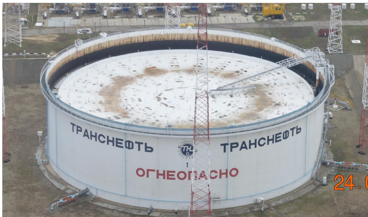
Рисунок 1 - Общий вид резервуара вертикального стального цилиндрического РВСПК-50000
