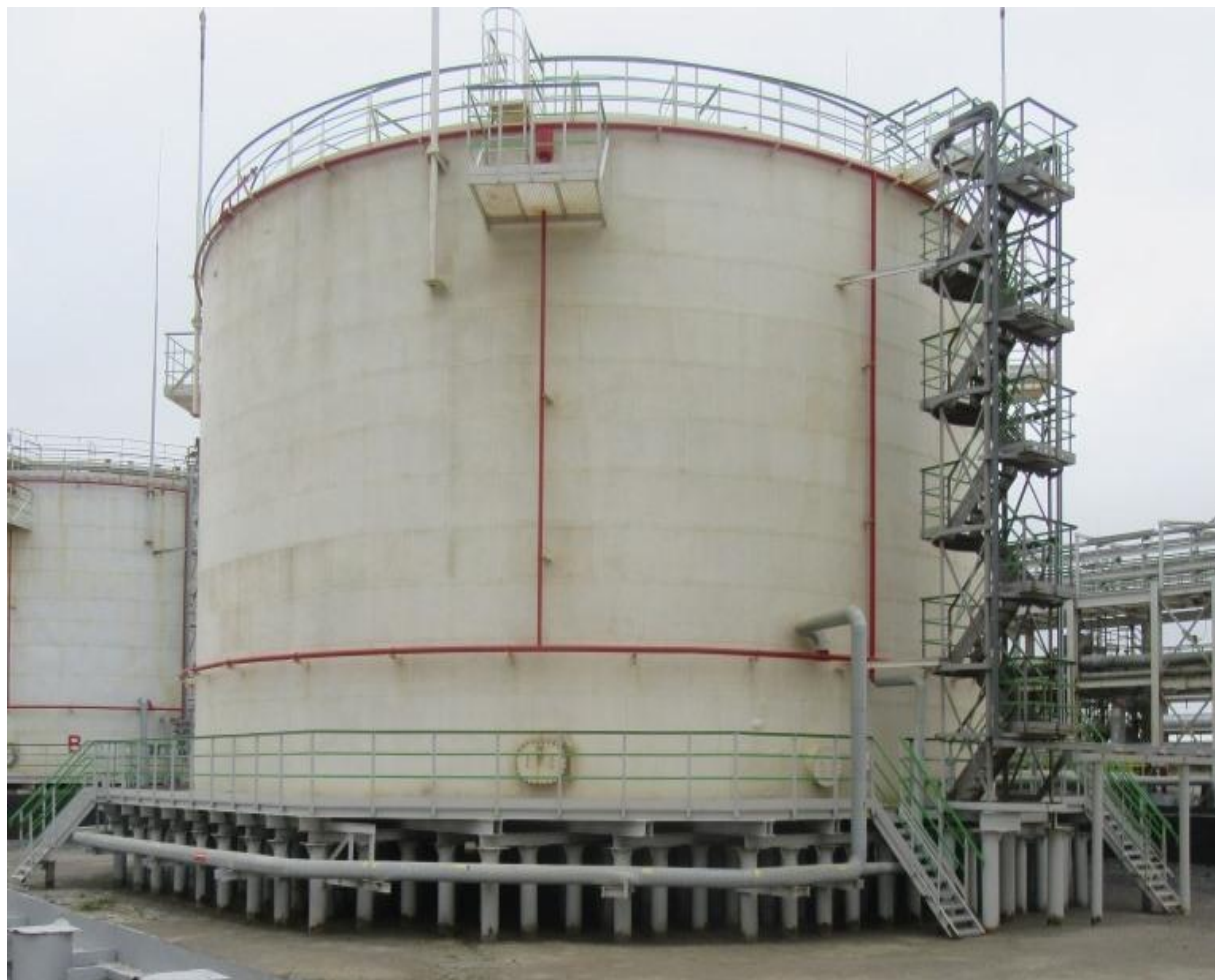
Рисунок 1 - Общий вид резервуара стального вертикального цилиндрического РВС-5000
