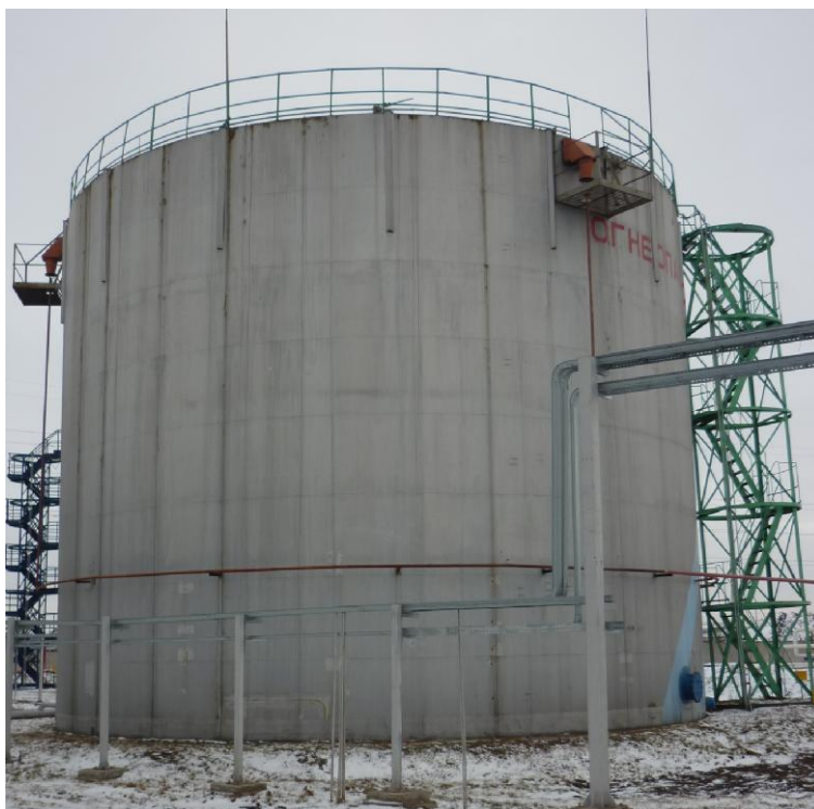
Рисунок 2 - Общий вид резервуара вертикального стального цилиндрического РВС-2000
