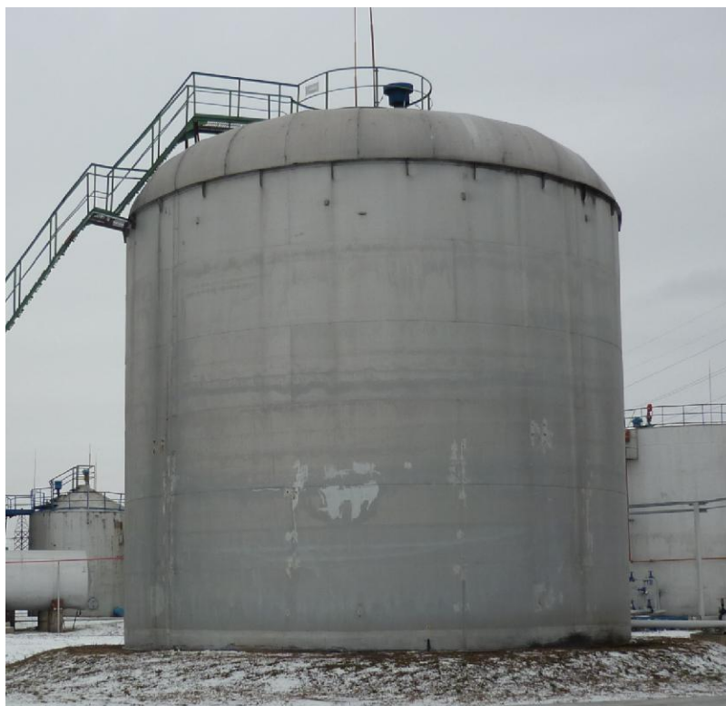
Рисунок 1 - Общий вид резервуара вертикального стального цилиндрического РВС-700
