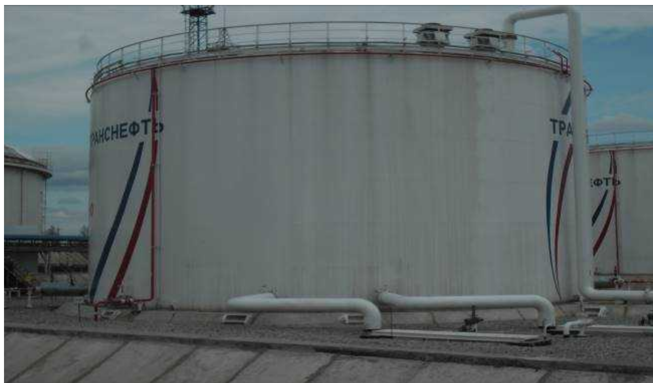
Рисунок 2 - Общий вид резервуара вертикального стального цилиндрического РВСП-5000
