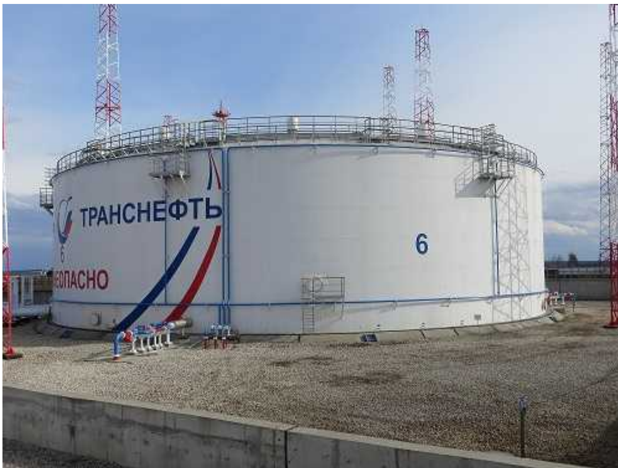
Рисунок 3 - Общий вид резервуара вертикального стального цилиндрического РВСП-20000
