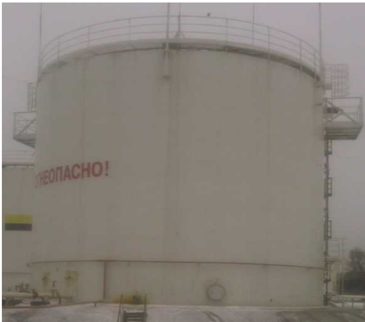
Рисунок 1 - Общий вид резервуара стального вертикального цилиндрического РВСП-2000
