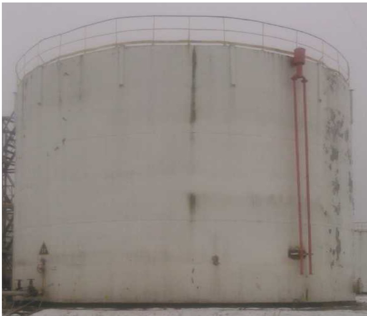
Рисунок 1 - Общий вид резервуара стального вертикального цилиндрического РВС-1000
