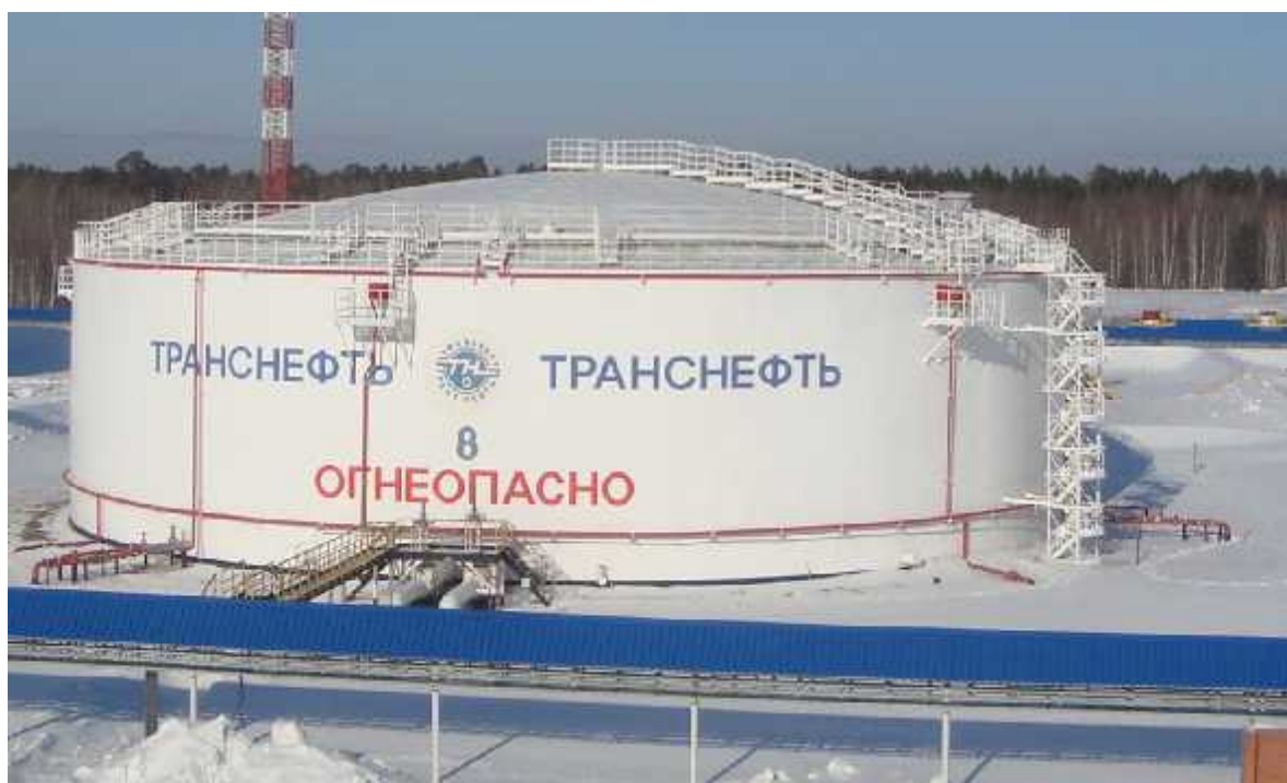
Рисунок 2 - Общий вид резервуара вертикального стального цилиндрического РВСП-20000
