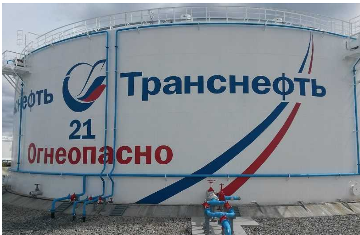
Рисунок 2 - Общий вид резервуара вертикального стального цилиндрического RVСП-20000
