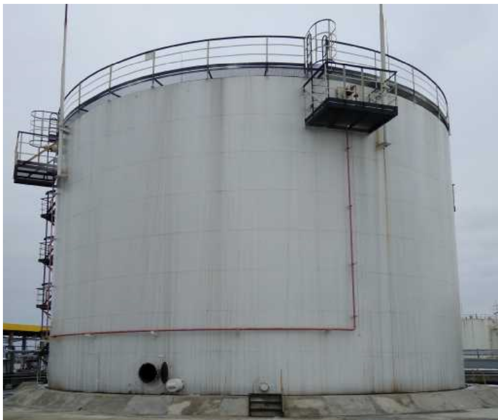
Рисунок 3 - Общий вид резервуара стального вертикального цилиндрического РВС-3000
