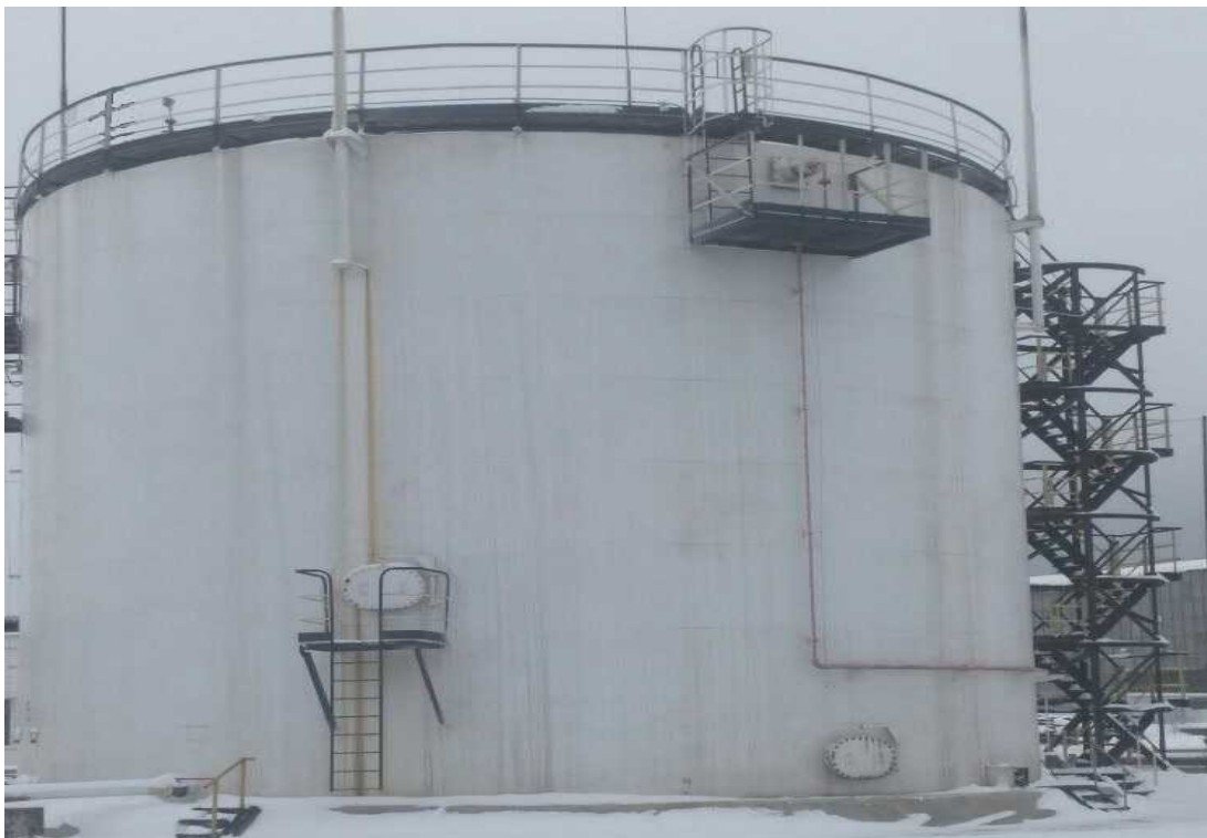
Рисунок 1 - Общий вид резервуара стального вертикального цилиндрического РВС-2000
