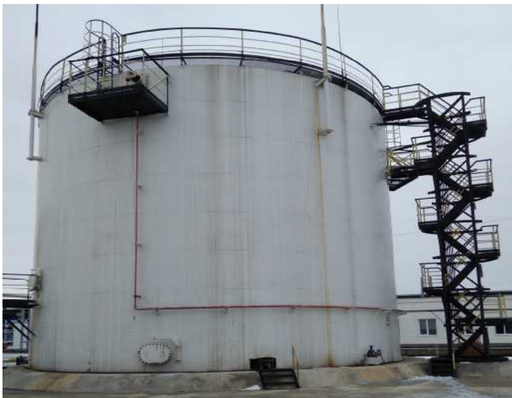
Рисунок 2 - Общий вид резервуара стального вертикального цилиндрического РВСП-2000
