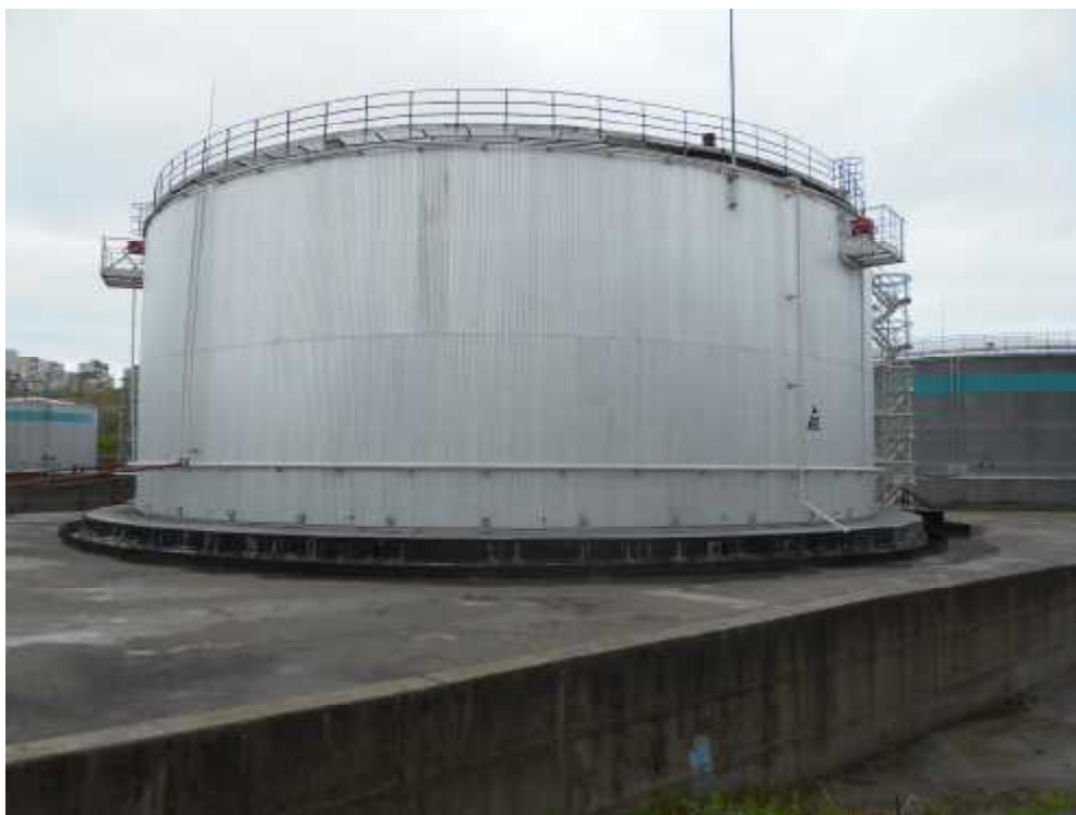
Рисунок 2 - Общий вид резервуара РВС-10000 № 23
