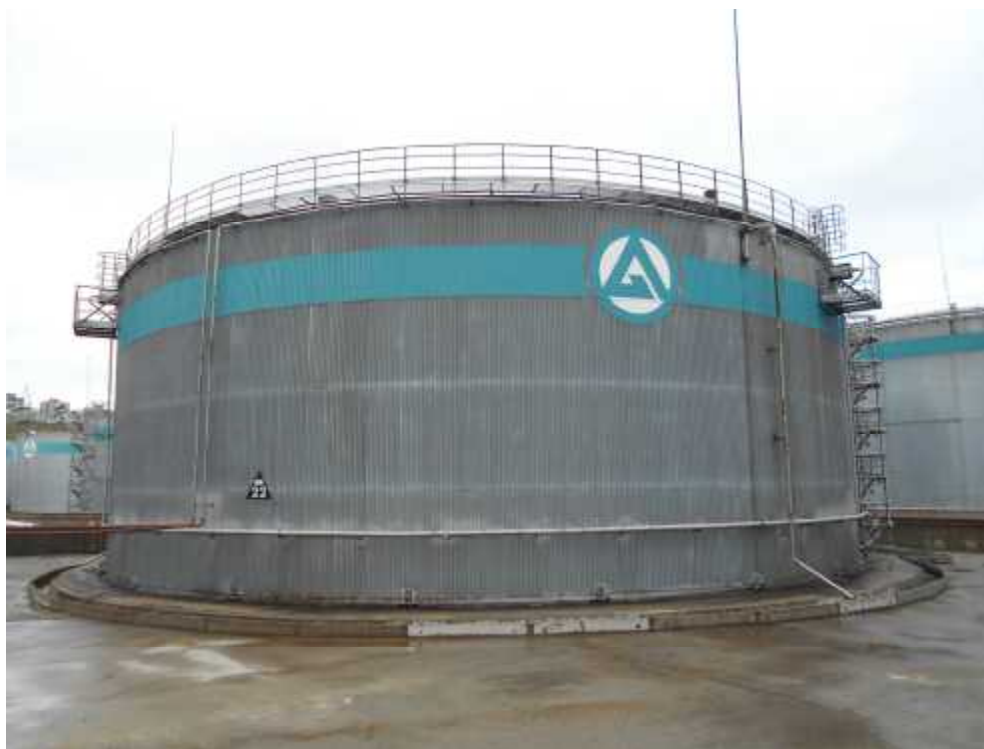
Рисунок 1 - Общий вид резервуара РВС-10000 № 22
