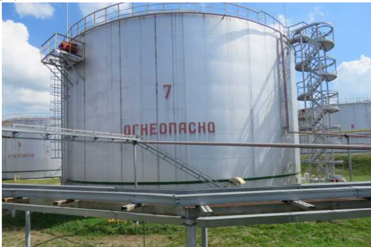
Рисунок 1 - Общий вид резервуара РВС-5000
