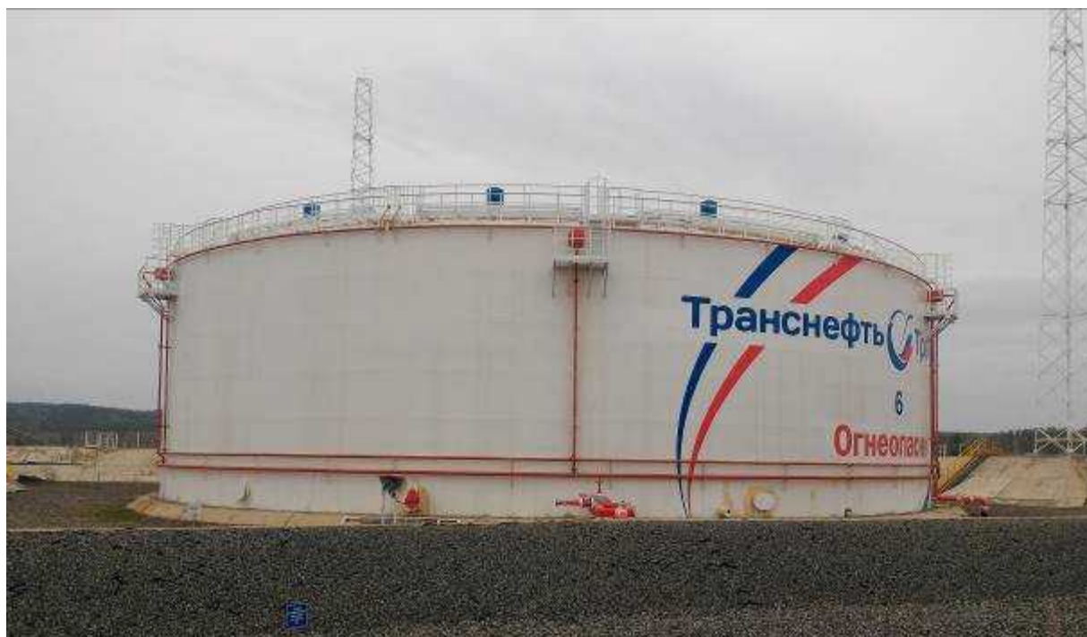
Рисунок 2 - Общий вид резервуара вертикального стального цилиндрического RVSP-20000
