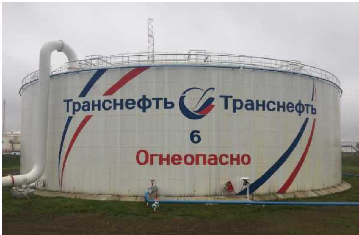
Рисунок 3 - Общий вид резервуара вертикального стального цилиндрического РВСП-20000
