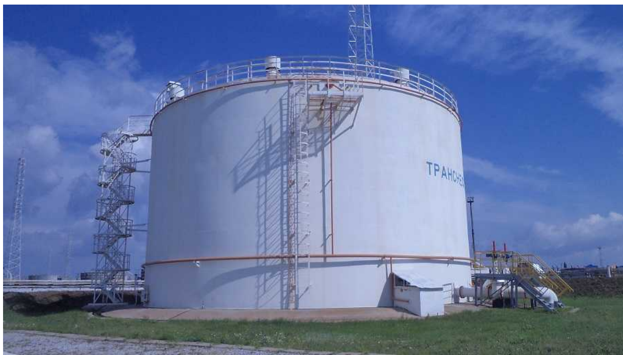
Рисунок 2 - Общий вид резервуара вертикального стального цилиндрического RVSP-5000
