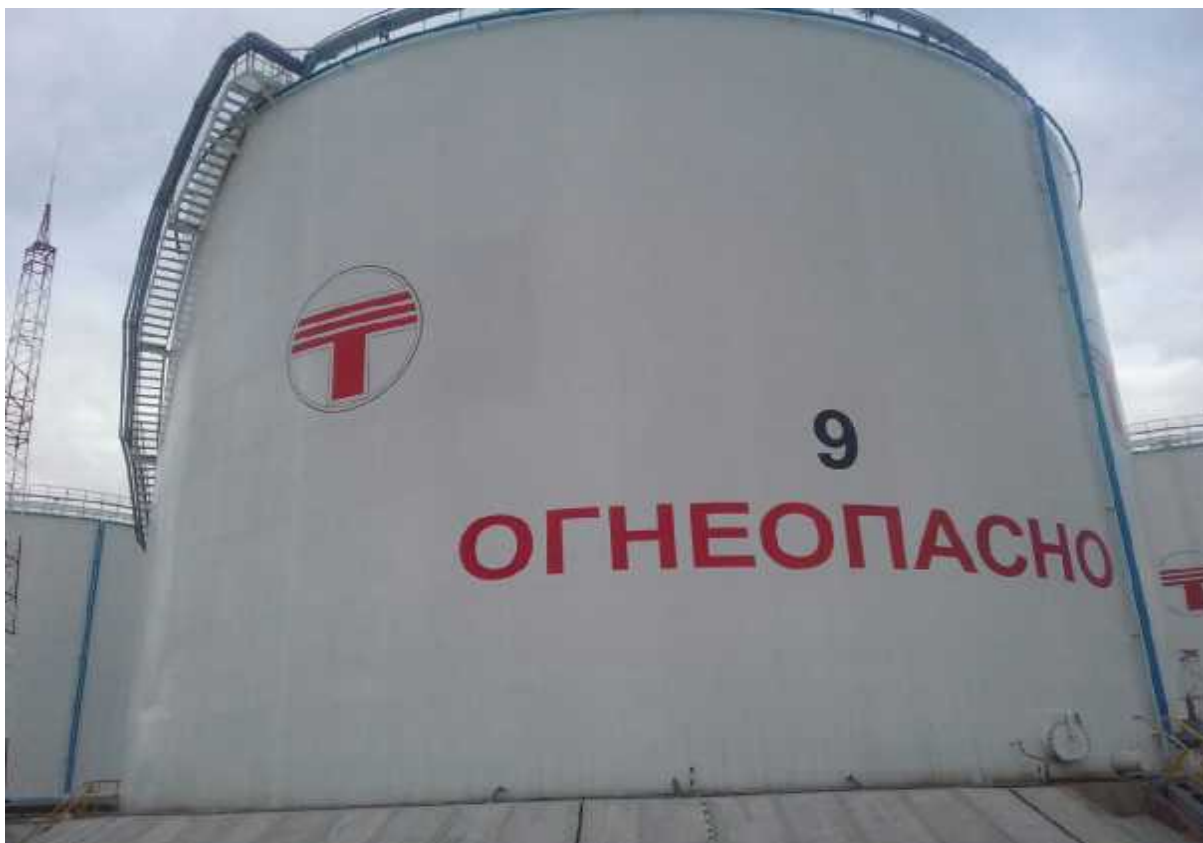
Рисунок 1 - Общий вид резервуара вертикального стального цилиндрического РВС-10000
