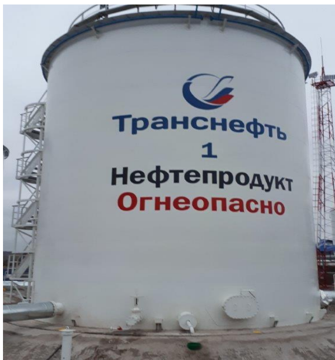
Рисунок 1 - Общий вид резервуара вертикального стального цилиндрического РВС-1000
