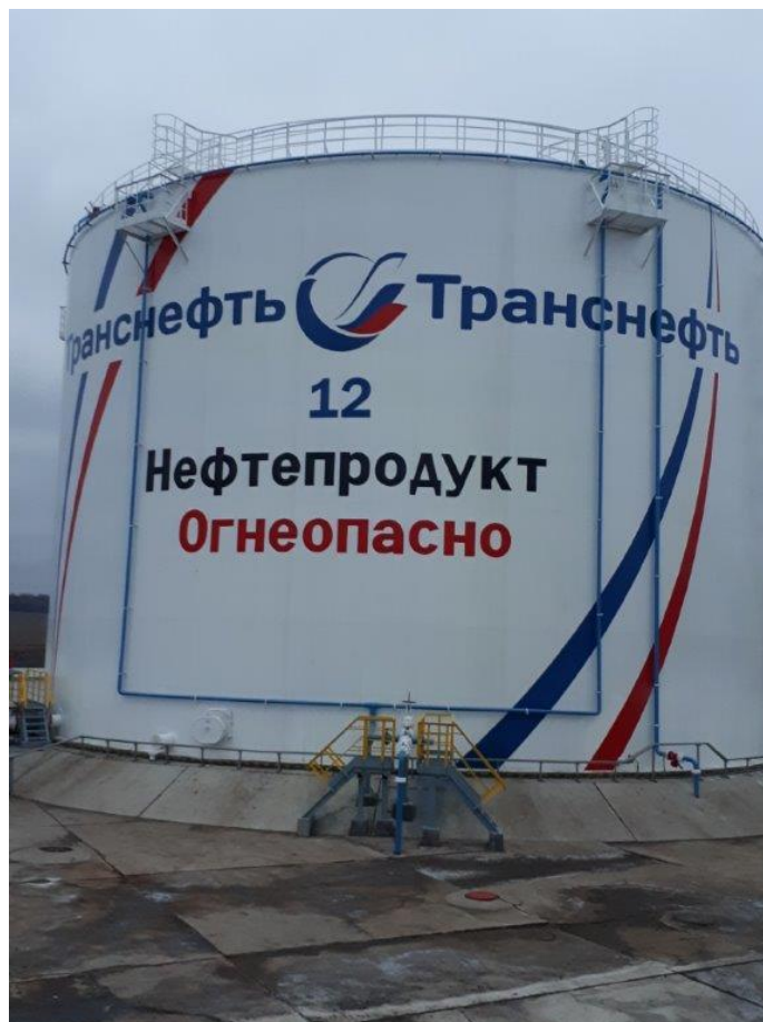
Рисунок 2 - Общий вид резервуара вертикального стального цилиндрического РВС-10000
