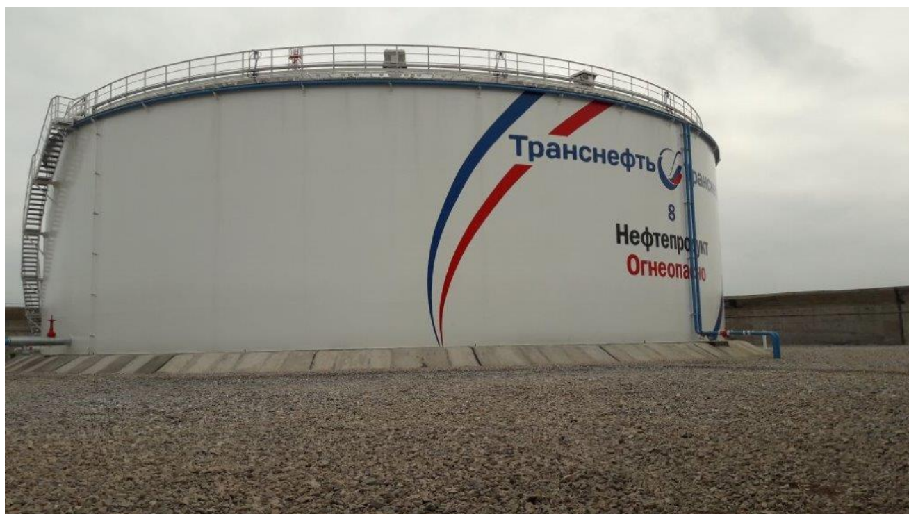
Рисунок 3 - Общий вид резервуара вертикального стального цилиндрического РВС-20000
