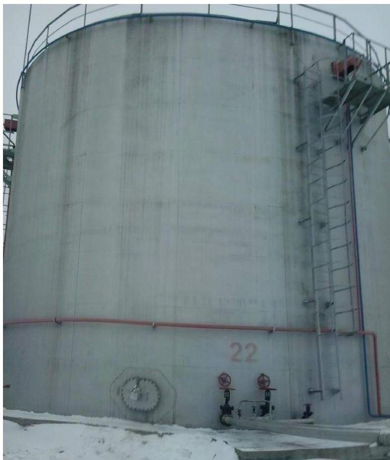
Рисунок 1 - Общий вид резервуара вертикального стального цилиндрического РВС-2000
