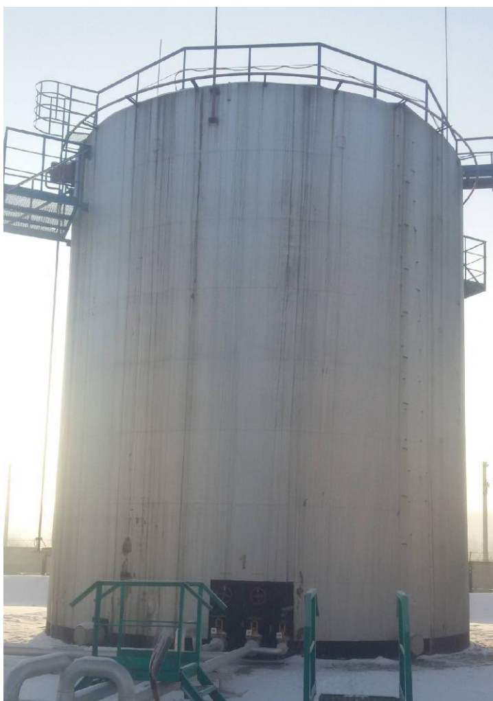
Рисунок 1 - Общий вид резервуара вертикального стального цилиндрического РВС-1000
