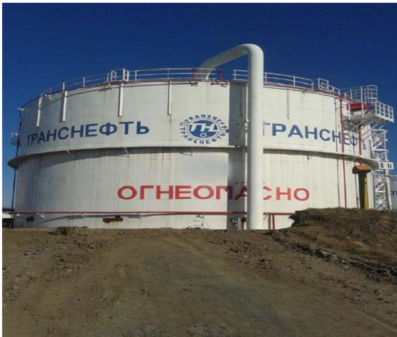
Рисунок 1 - Общий вид резервуара вертикального стального цилиндрического РВС-5000
