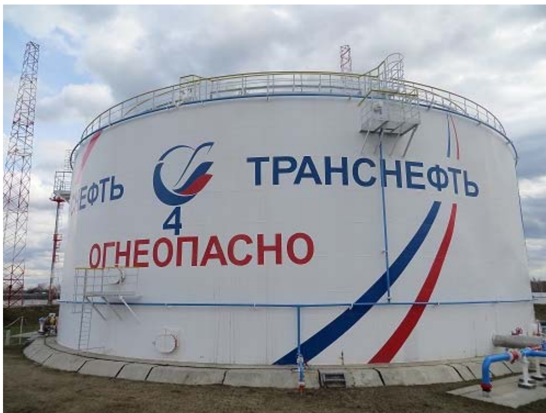
Рисунок 3 - Общий вид резервуара вертикального стального цилиндрического РВСП-10000
