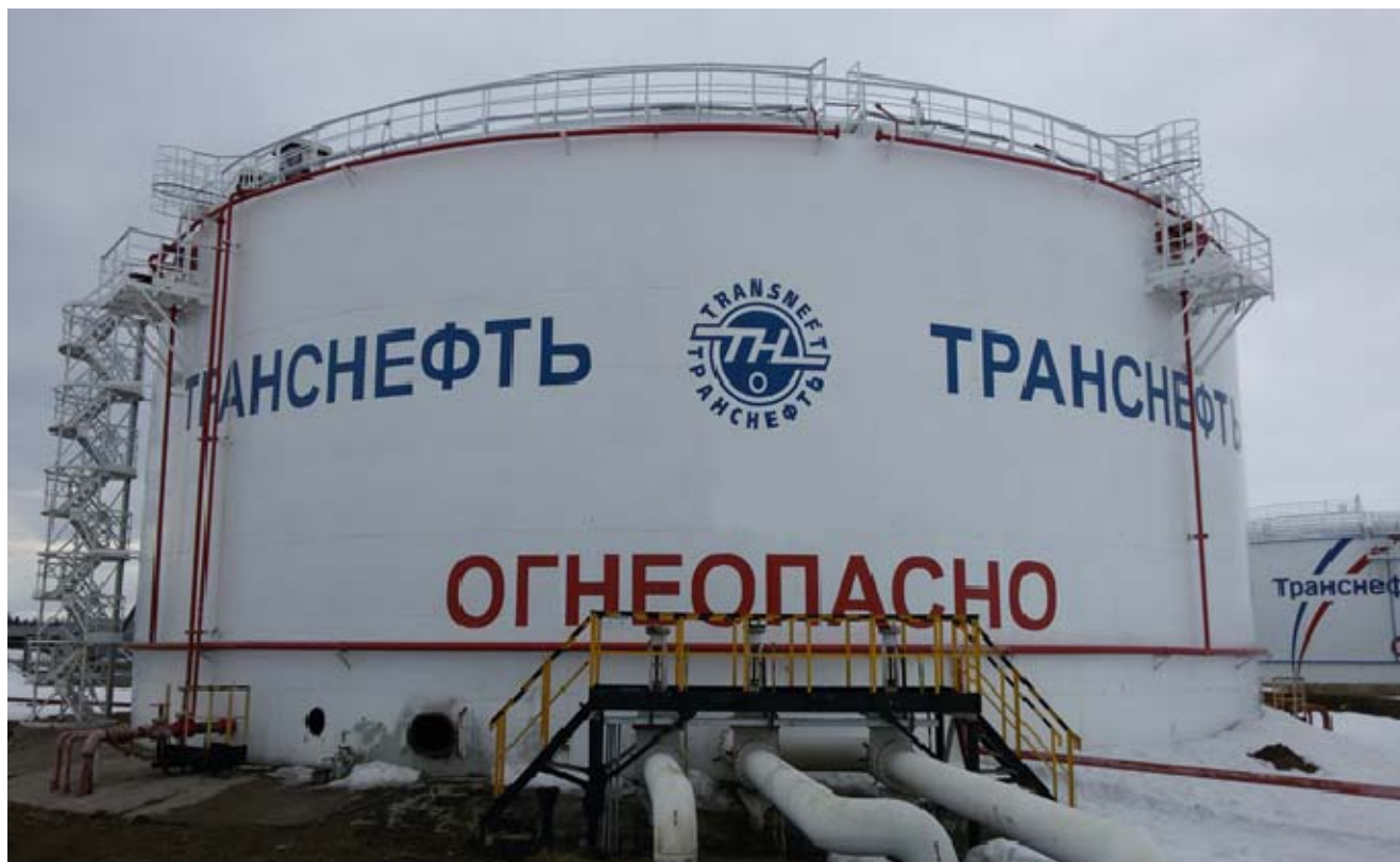
Рисунок 2 - Общий вид резервуара вертикального стального цилиндрического РВС-10000
