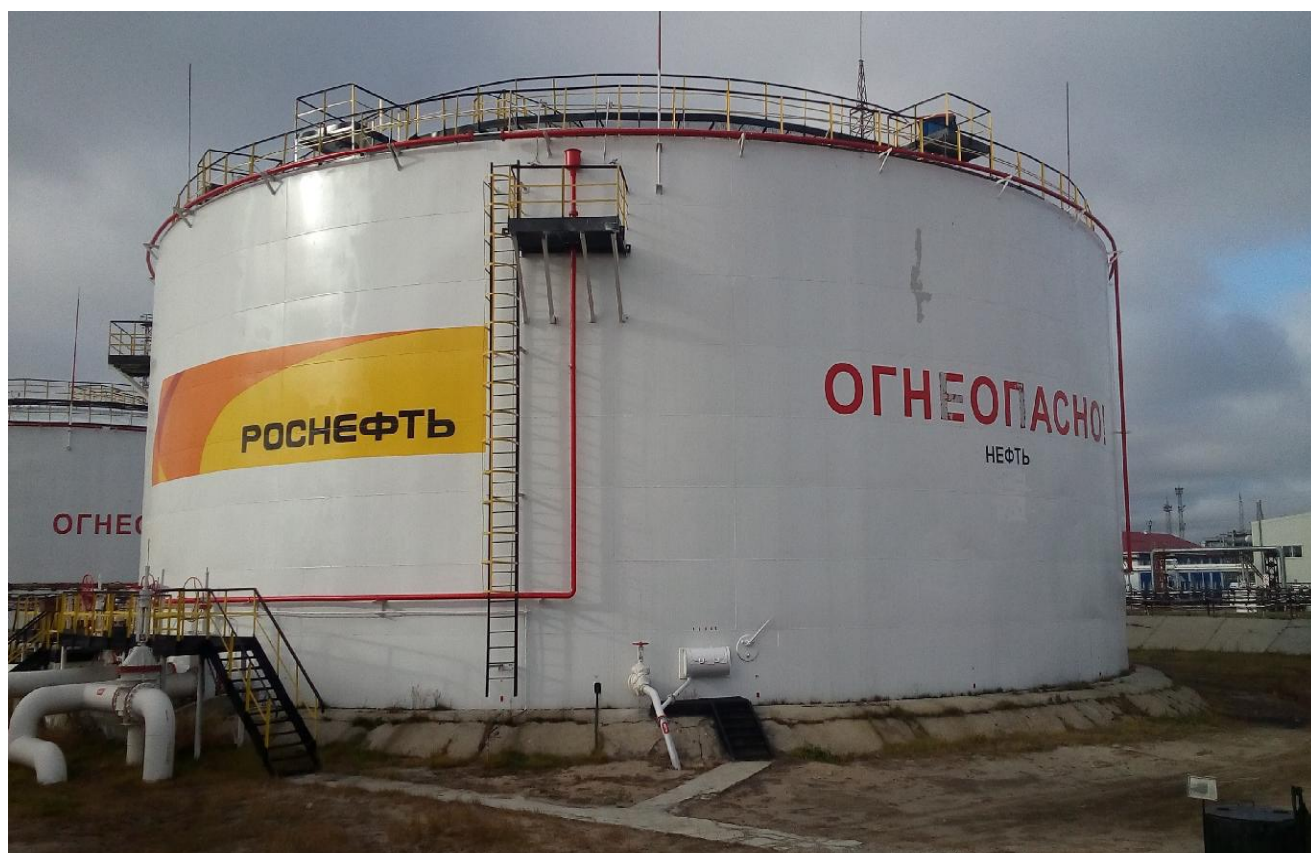
Рисунок 1 - Общий вид резервуара стального вертикального цилиндрического РВС-10000
