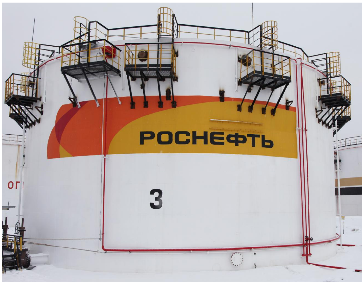
Рисунок 1 - Общий вид резервуара стального вертикального цилиндрического РВС-5000
