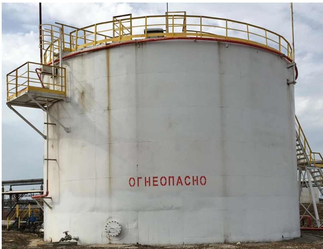
Рисунок 3 - Общий вид резервуара стального вертикального цилиндрического РВС-1000
