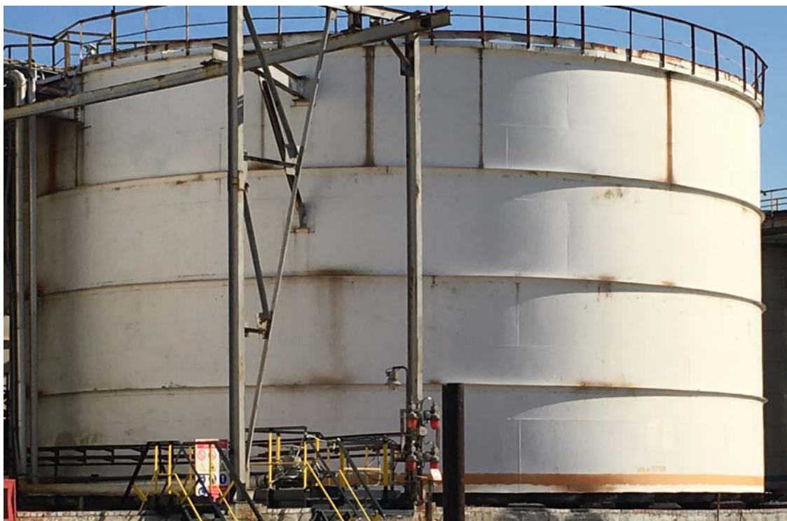
Рисунок 4 - Общий вид резервуара стального вертикального цилиндрического РВС-2000
