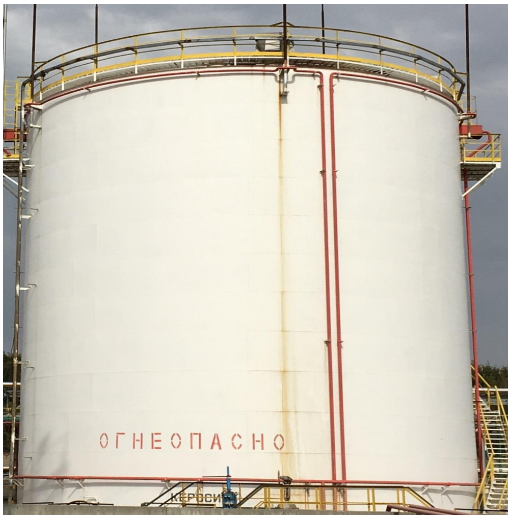
Рисунок 1 - Общий вид резервуара стального вертикального цилиндрического РВС-3000
