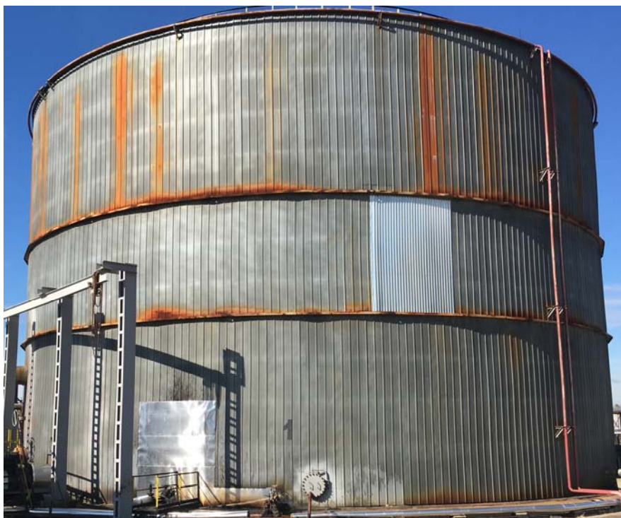
Рисунок 1 - Общий вид резервуара стального вертикального цилиндрического РВС-10000
