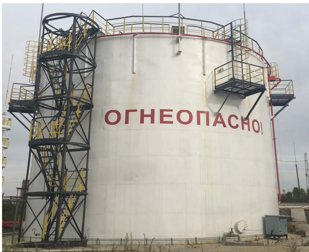
Рисунок 2 - Общий вид резервуара стального вертикального цилиндрического РВСП-2000
