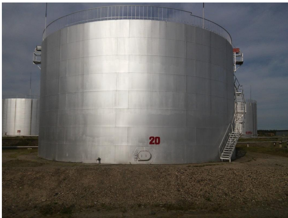
Рисунок 5 - Общий вид резервуара РВС-5000
