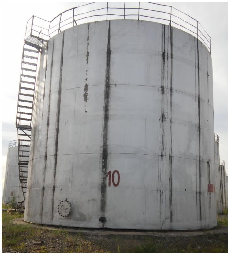
Рисунок 1 - Общий вид резервуара РВС-700
