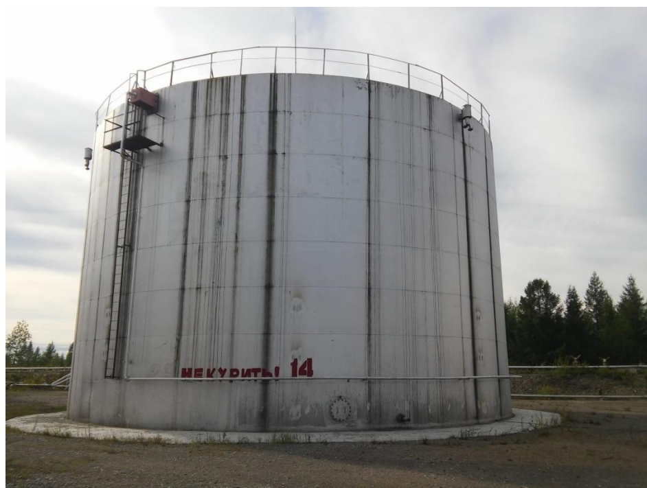
Рисунок 4 - Общий вид резервуара РВС-3000
