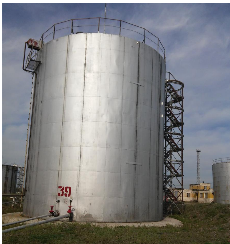
Рисунок 2 - Общий вид резервуара РВС-1000
