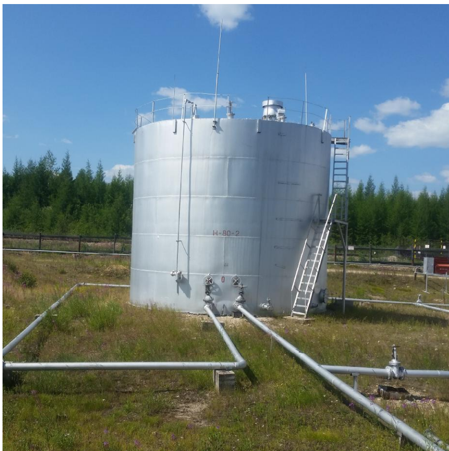
Рисунок 1 - Общий вид резервуара РВС-400
