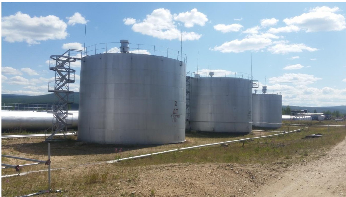
Рисунок 2 - Общий вид резервуара РВС-1000
