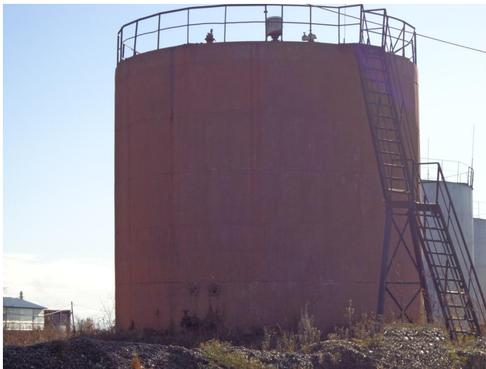
Рисунок 1 - Общий вид резервуара РВС-400
