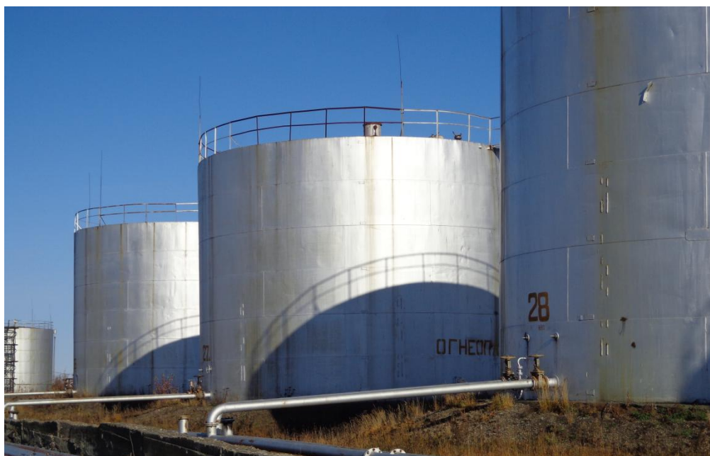
Рисунок 3 - Общий вид резервуара РВС-1000
