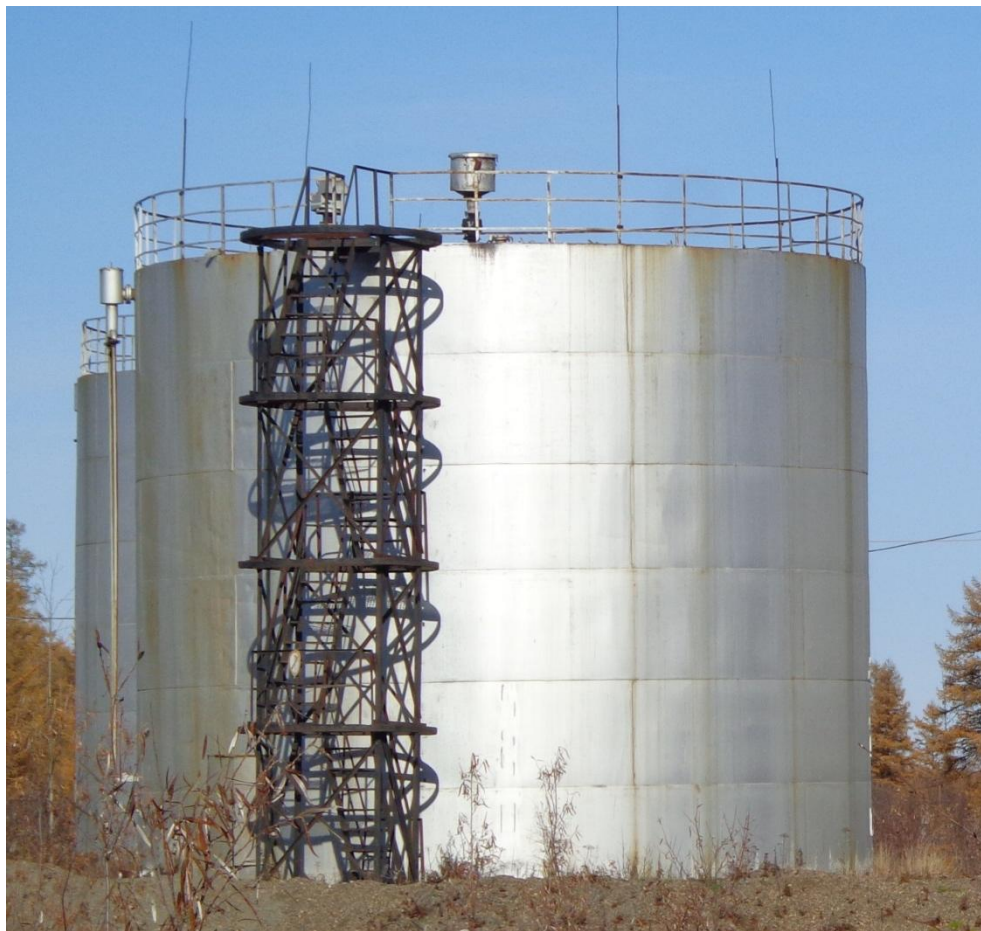
Рисунок 2 - Общий вид резервуара РВС-700
