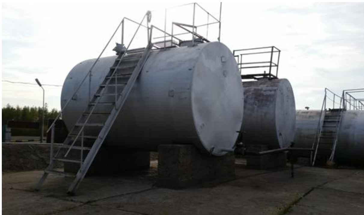
Рисунок 1 - Общий вид резервуара РГС-25
