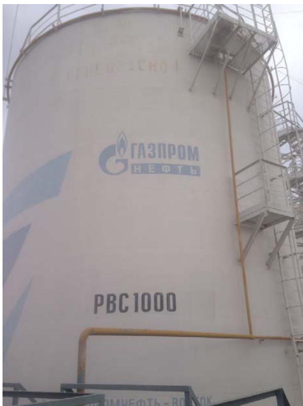
Рисунок 1 - Общий вид резервуара
