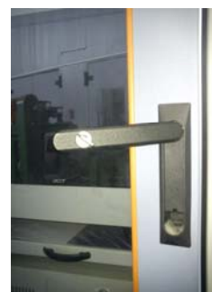
Рисунок 6 - Внешний вид замка на дверце стойки управления
