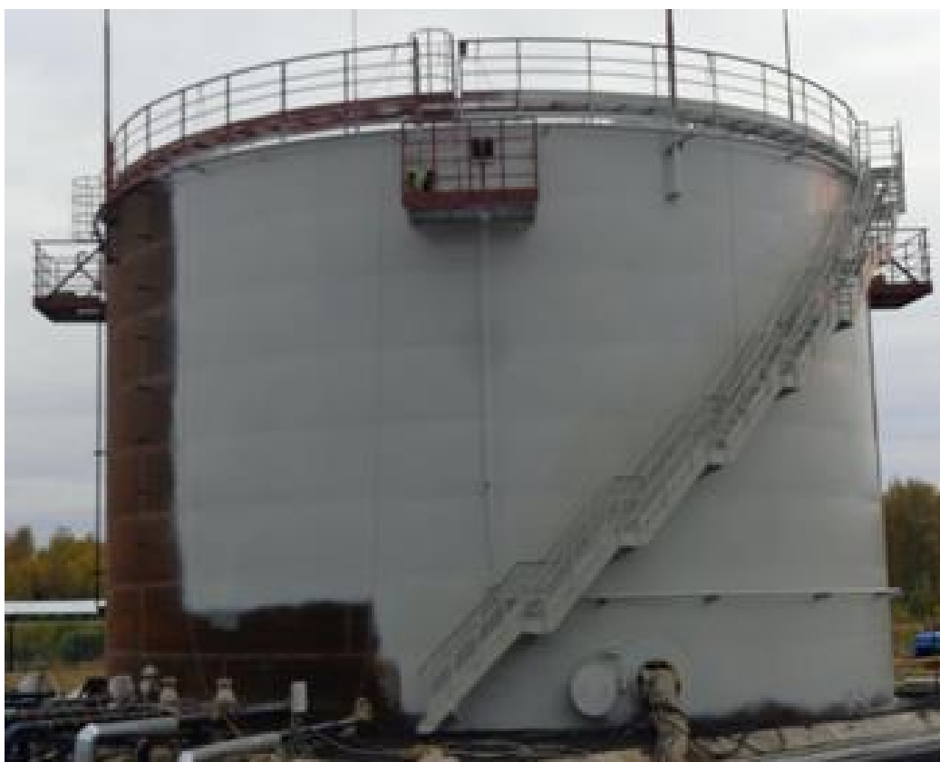
Рисунок 1 – Общий вид резервуара
