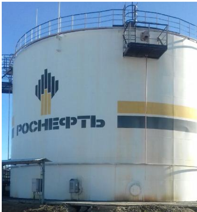
Рисунок 1 - Общий вид резервуара
