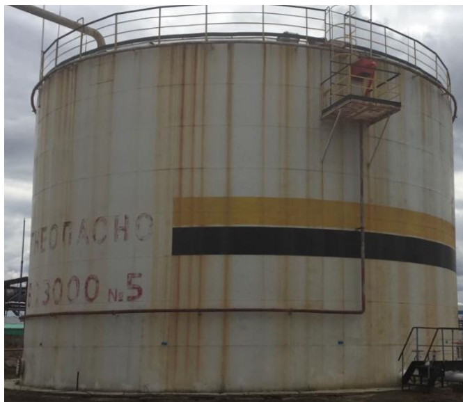
Рисунок 1 - Общий вид резервуара РВС-3000 № 5
