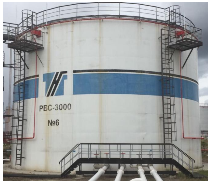
Рисунок 2 - Общий вид резервуара РВС-3000 № 6
